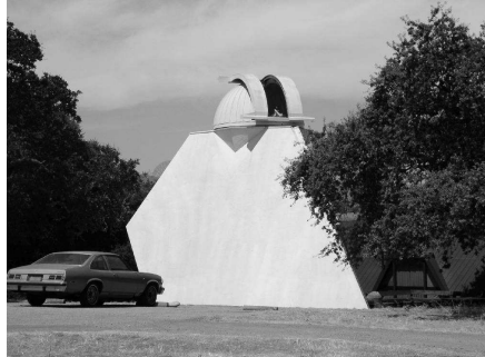
Věž a kopule Wilcoxovy sluneční observatoře. V kopuli se nachází coelostat, jehož pomocné zrcadlo je viditelné ve štěrbině.
